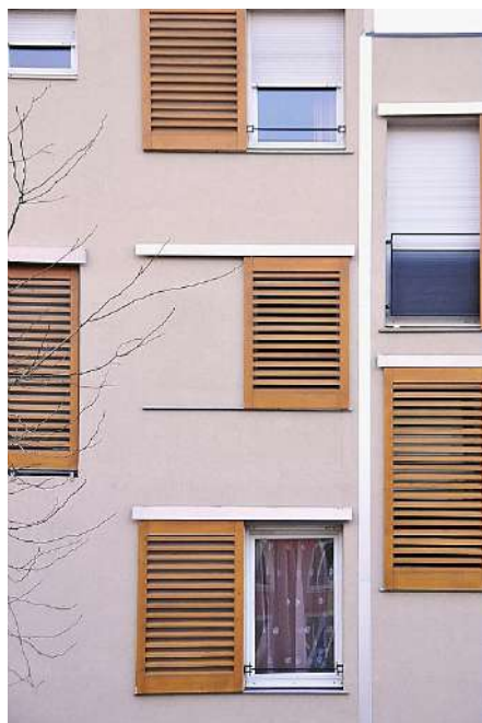
Volets brises-soleil coulissants, Oullins. © Ruch M-P./Agence d'urbanisme de Lyon.
