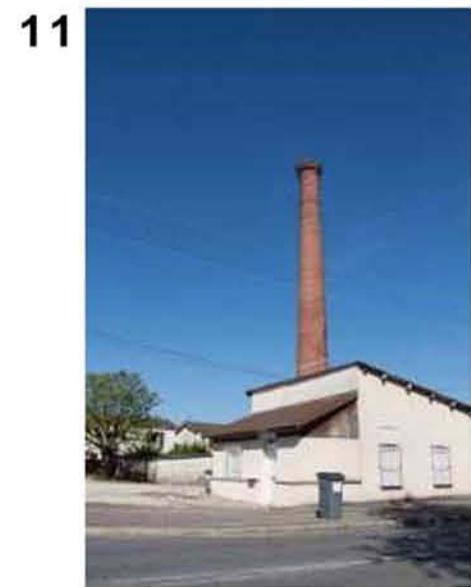
11 Ancienne usine à valoriser
