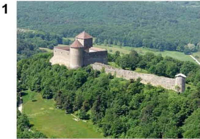
Finir les travaux de restauration des Allymes
