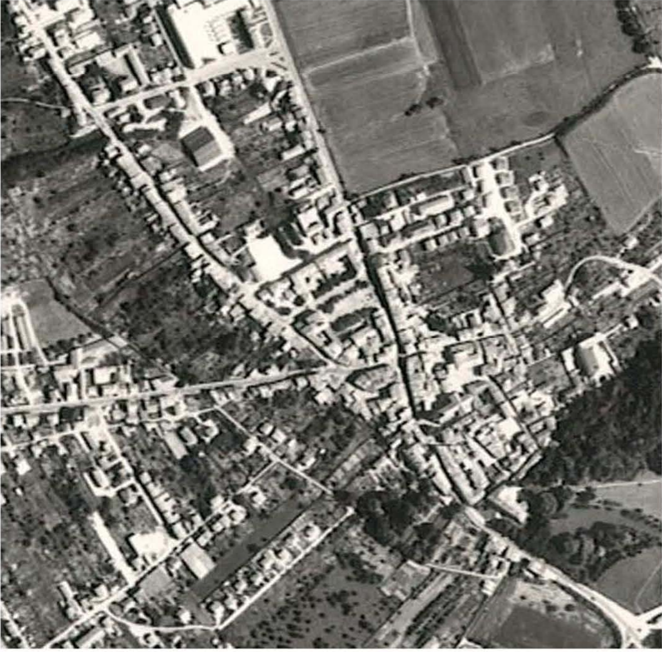
Photo aérienne - années 60 Archives départementales de l'Ain
