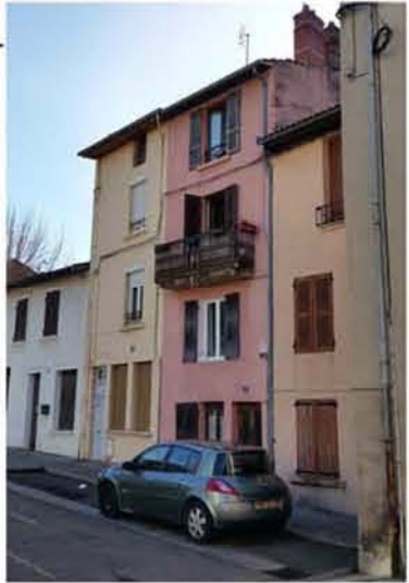
Surélévation d'un niveau et ajout d'un balcon au R+1
