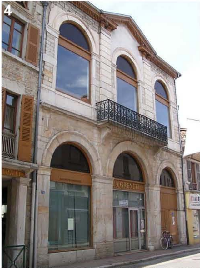
La médiathèque - ancienne halle de la Grenette - édifice de 1841 sur implantation médiévale
