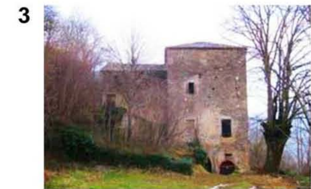
Tour de Savoie à restaurer
