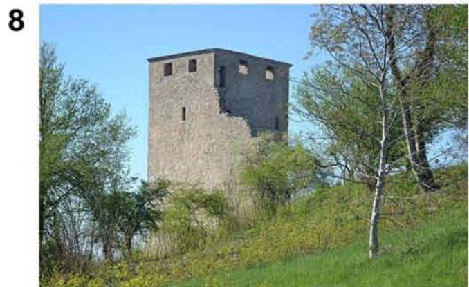
8 Tour de saint-Denis à restaurer
