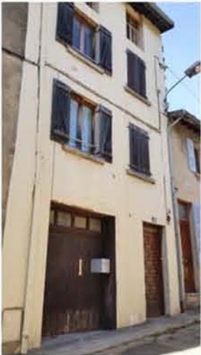
Surélévation d'un niveau
