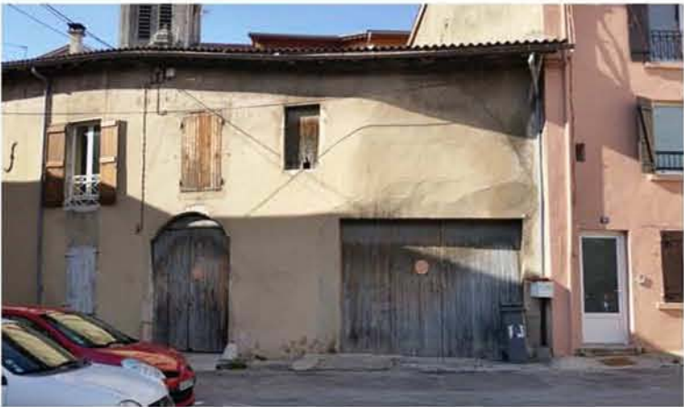
modification de la porte cintrée en porte à linteau béton
